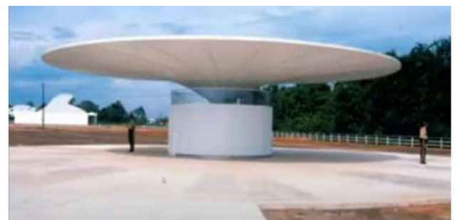
A estrutura metálica.
