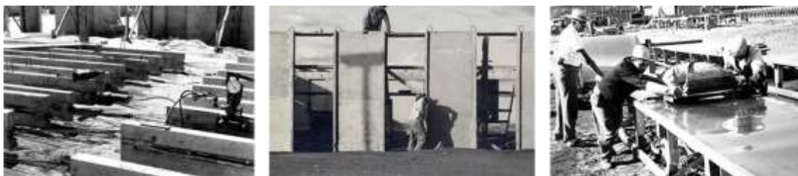
Figura 6: Protensão nas vigas, montagem dos painéis e dobra da cobertura em alumínio Acervo Universidade de Brasília
