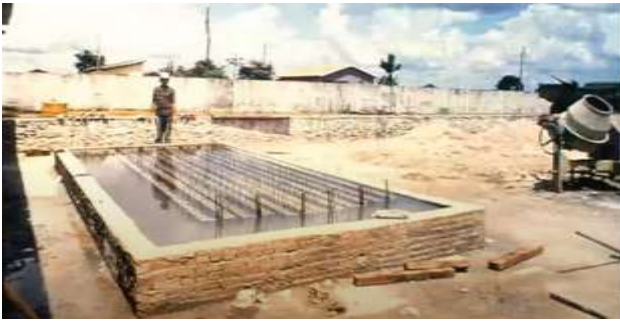
O tanque de cura abaixo.
