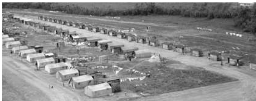
Figura 3: construções modulares de áreas básicas para acampamento em Brasília Acervo Arquivo Público do Distrito Federal
