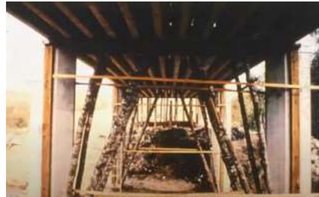
A concretagem de segunda fase, do Tabuleiro.
