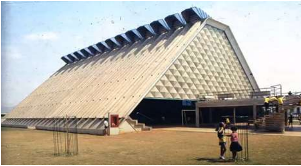
O ginásio com sistema de sheds.
