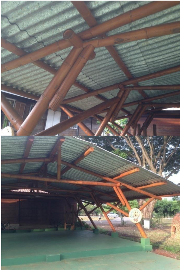
Figura 22: pavilhão de atividades (detalhe) - estrutura completa em bambu apresentando ótimo estado de conservação e boa resistência às cargas e intempérie (acervo pessoal)
