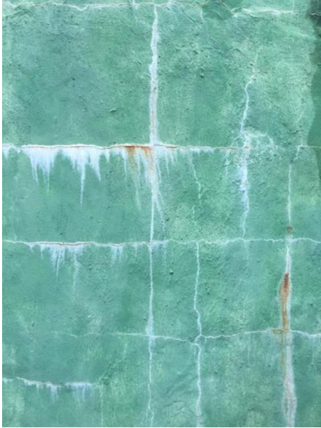
Figura 4: Tanque de ferro cimento - armazenamento de água pluvial (acervo pessoal)
