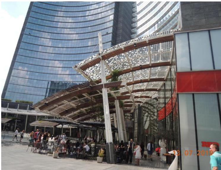
Figura 3: Painéis fotovoltaicos em centro comercial, fachada e cobertura, bairro Porta Nova, Milão.
