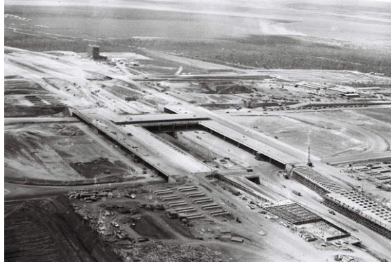
FIGURA 41. Construção da Rodoviária de Brasília.
