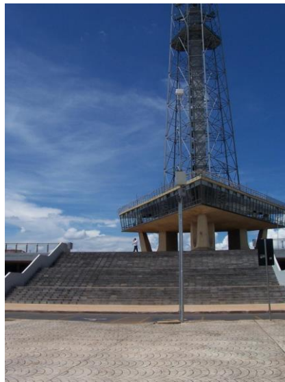
FIGURA 17. Escadaria de acesso à plataforma da Torre de TV de Brasília.
