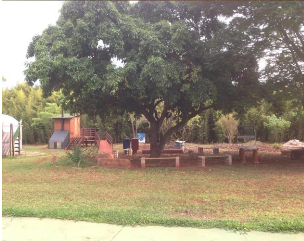
Figura 20: casa experimental (detalhe) - treliça de bambu sustentação da cobertura (acervo pessoal)
