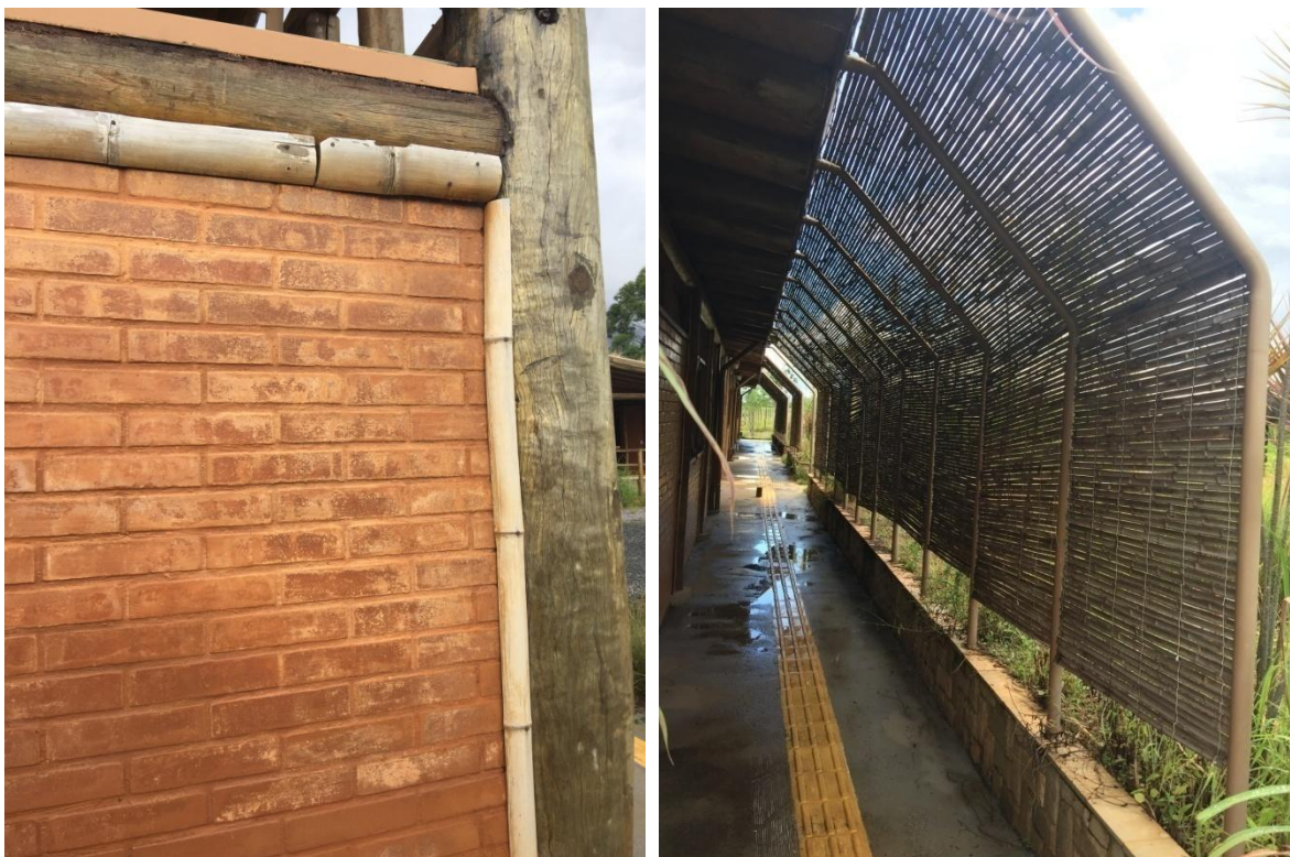
Figura 16: pavilhão de oficinas (detalhe) - estrutura em madeira e vedação em parede de tijolo solocimento bom estado de conservação e resistente ao tempo (acervo pessoal)
