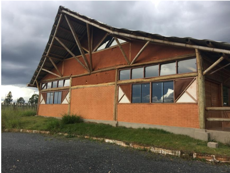
Figura 9: pavilhão de oficinas e sanitários - paredes em taipa de mão e estrutura mista de madeira e bambu (acervo pessoal)
