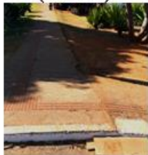
Figura 1: Piso tátil (entrada)
