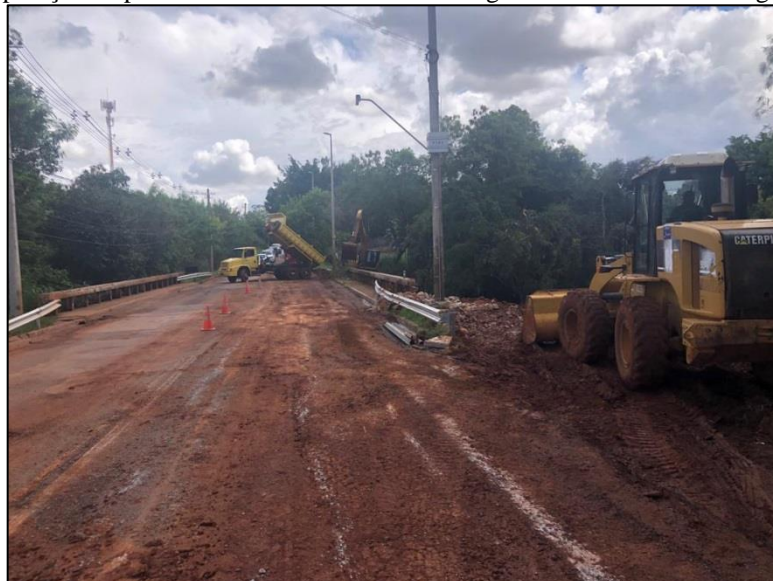
Figura 32 - Recuperação da ponte situada entre o Guará II e Águas Claras sobre o córrego Bernardo Sayão.
