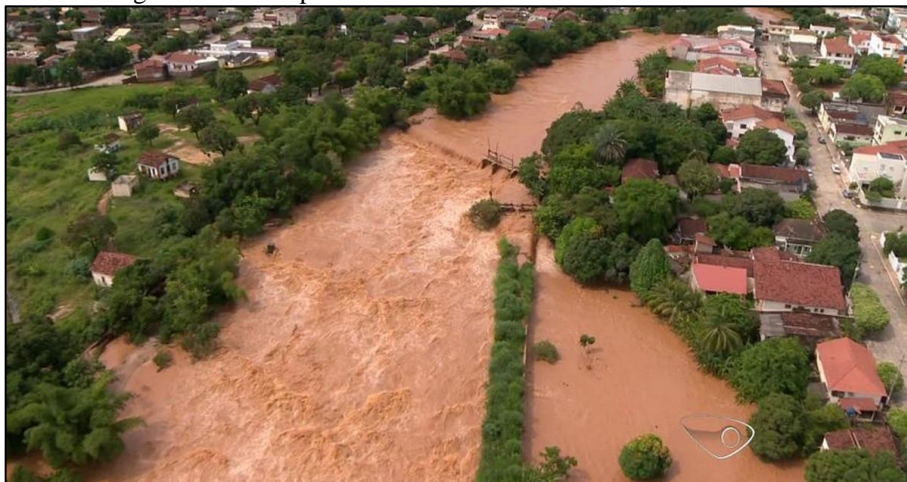
Figura 2 - Município de Baixo Guandu com estradas interditadas.
