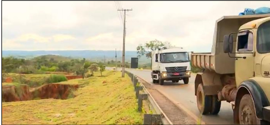
Figura 28 - Erosão às margens da DF-250.
