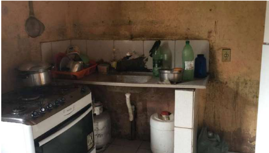
Imagens 133 à 137 – EC7.MRAA: Antes da intervenção.
