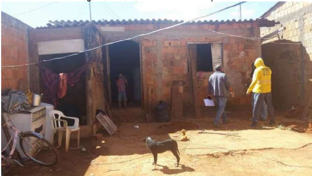
Imagem 94 – EC1.CMFS: Antes da intervenção SMH.
