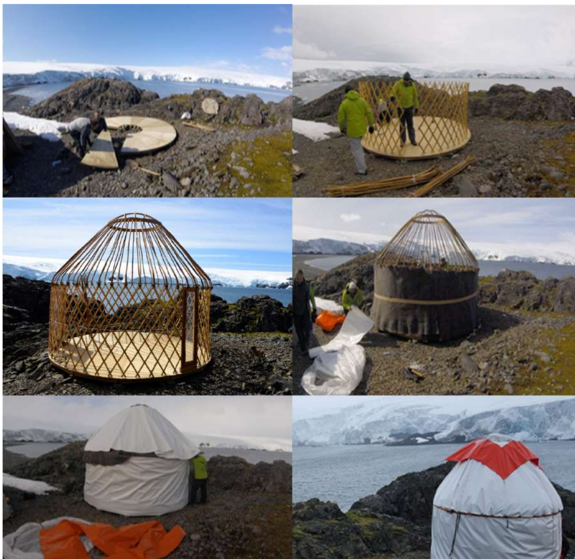
Figuras 11, 12, 13, 14, 15 e 16: Base circular com estrutura sanfonada e vedação em lã e mantas biodegradáveis. Fonte: Autor.
