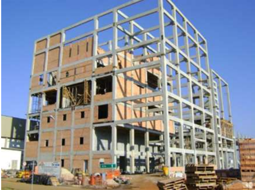
Figura 2 - Estrutura em concreto armado.
