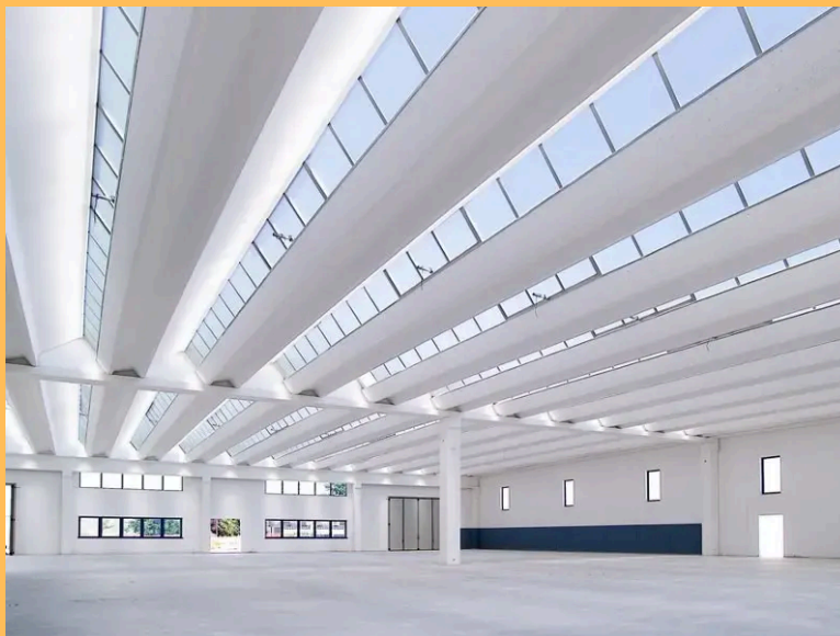
Figura 54 - Iluminação Zenital: shed - Link Imagem acesso: 09/06/2024
