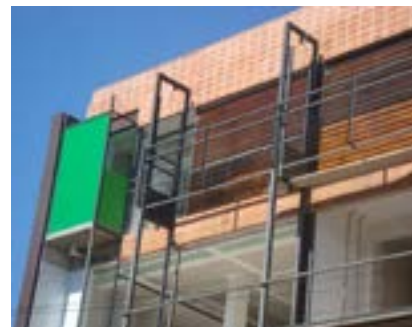
Figura 133- Reforma, instalação da estrutura externa
