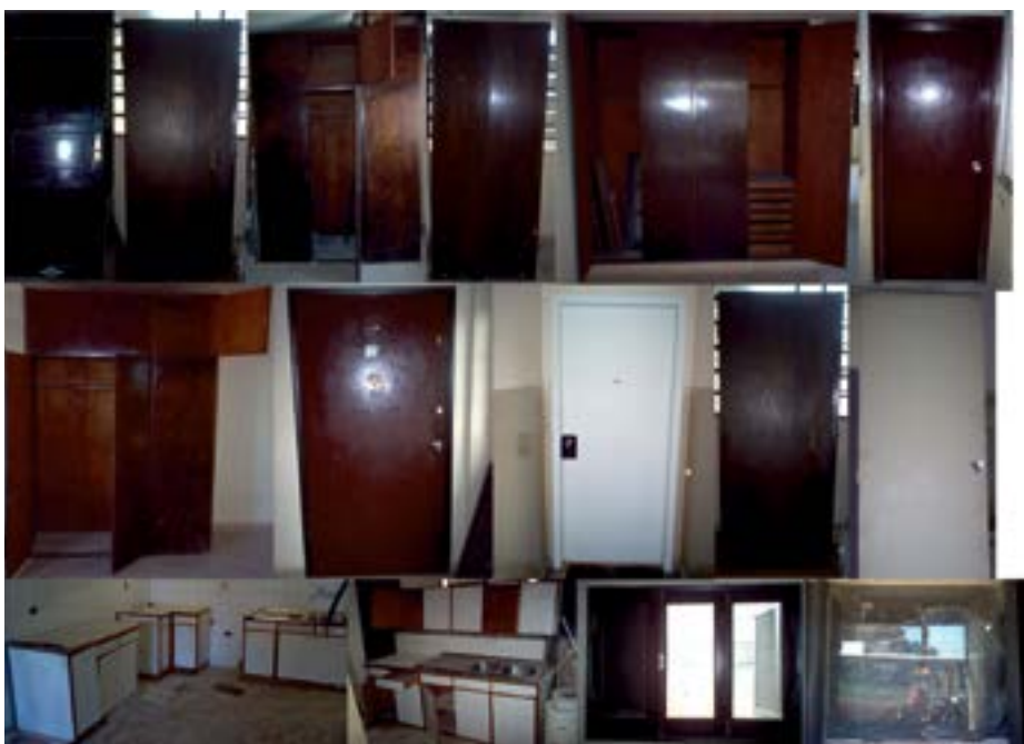
Figura 142- Colagem Portas presentes no edifício
