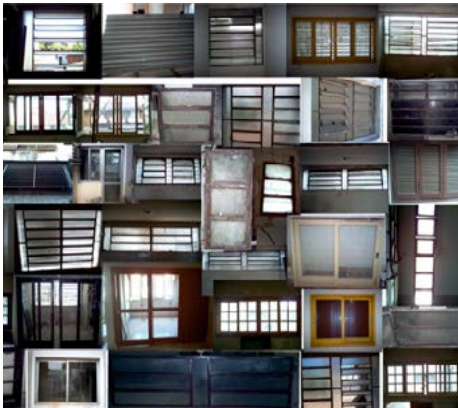
Figura 141- Colagem Janelas presentes no edifício
