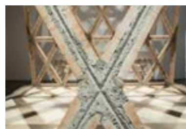
Figura 42- Detalhe junção tijolos
