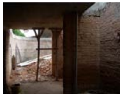
Figura 108- Sala de Jantar e Cozinha durante a reforma
