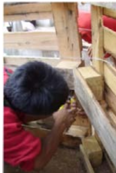
Figura 147- Montagem habitação de paletes
