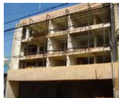
Figura 129- Reforma, instalação da estrutura externa
