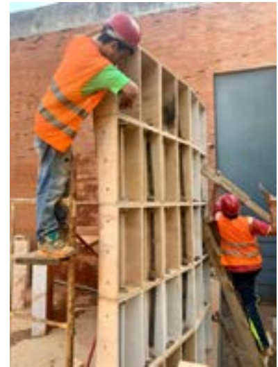
Figura 145- Construção Complexo Sanitário
