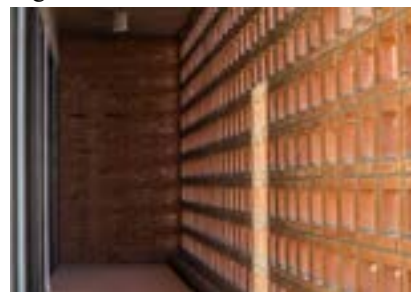
Figura 65- Vista interna San Francisco
