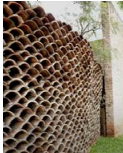
Figura 112- Parede feita com telha reutilizada, escritório Corvalán
