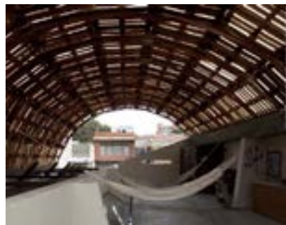
Figura 107- Vista varanda e cobertura
