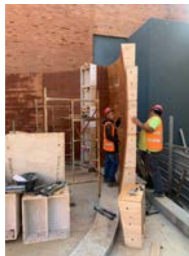
Figura 82- Montagem Formas
