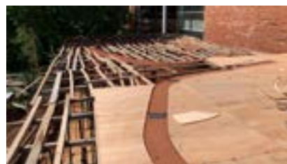
Figura 74- Concretagem da Laje
