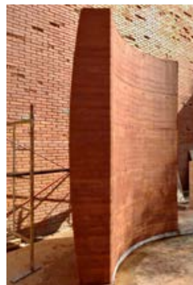
Figura 85- Parede de taipa finalizada
