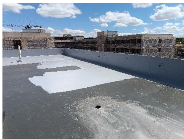
Figura 22: Aplicação de pintura de proteção (topcoat)
