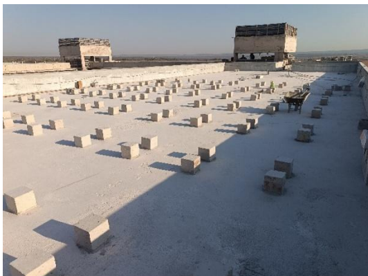
Figura 7: Bases das placas solares
