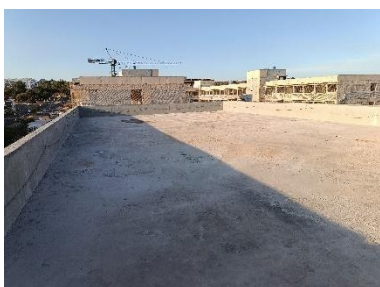
Figura 2: Laje antes de lixar
