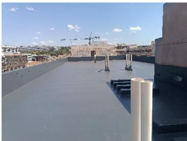
Figura 19: Poliureia aplicada junta A1
