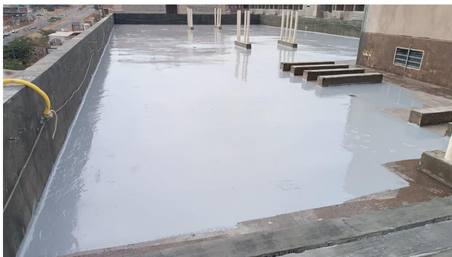
Figura 6: Membrana de pu aplicada na laje
