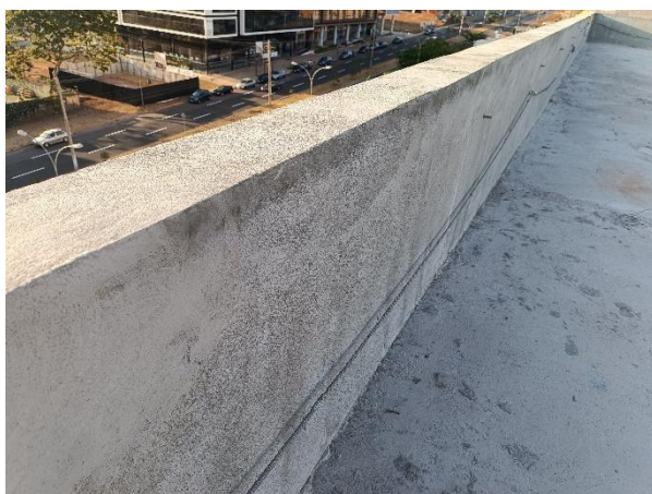
Figura 3: Regularização platibanda
