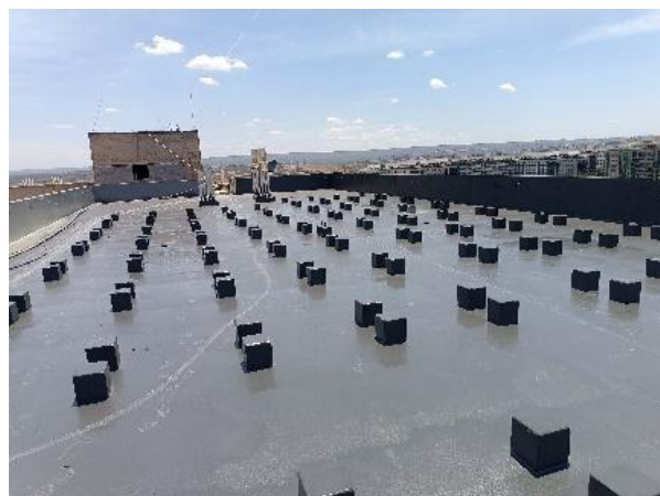
Figura 20: Poliureia aplicada junta A2
