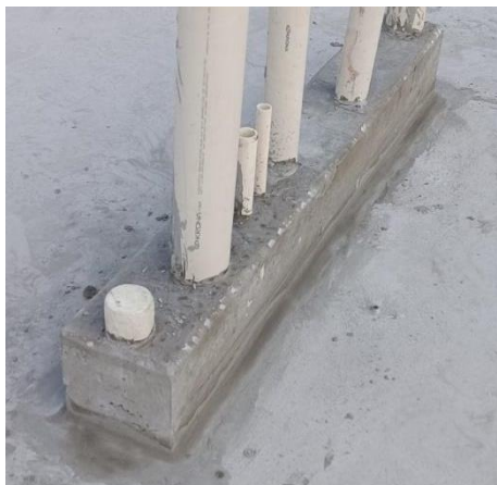
Figura 12: Abaulamento das quinas das bases de tubos
