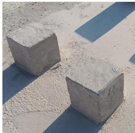
Figura 13: Abaulamento das quinas das bases das placas solares
