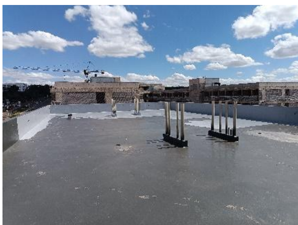
Figura 21: Aplicação de pintura de proteção (topcoat)
