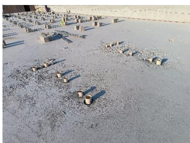
Figura 9: Grauteamento de tubos
