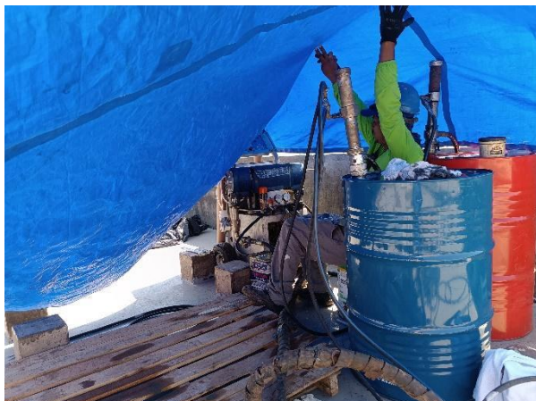
Figura 16: Máquina conectada aos tambores de poliureia
