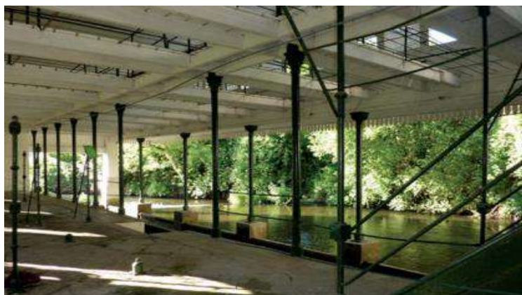
Figura 27 – Lavanderia Pública, piso térreo.
