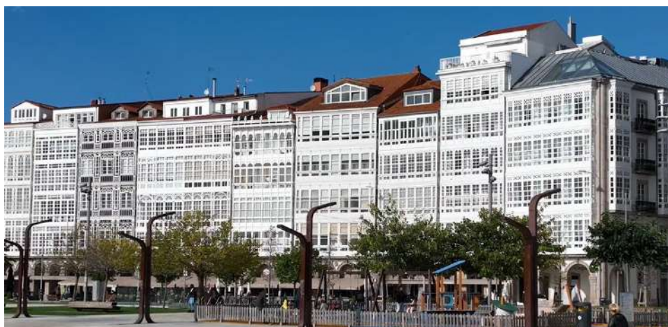
Figura 21 - Conjunto de fachadas envidraçadas – Av. da Marina, Porto da Coruña.
