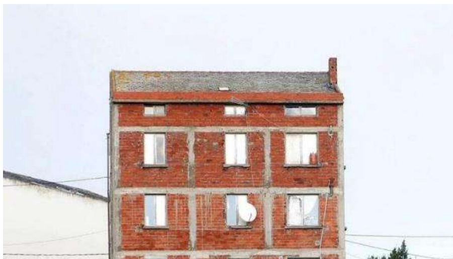
Figura 3: Fachada de tijolos em edifício na Galícia
