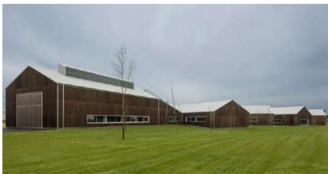
Figura 80: Norvento . Francisco Mangado, 2011-2016
